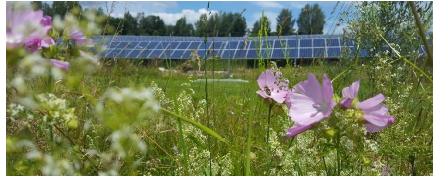
Solarfeld Oberndorf (84155) – Mit derzeit 500 dokumentierten Tier- und Pflanzenarten die umweltfreundlichste Solaranlage Bayerns
